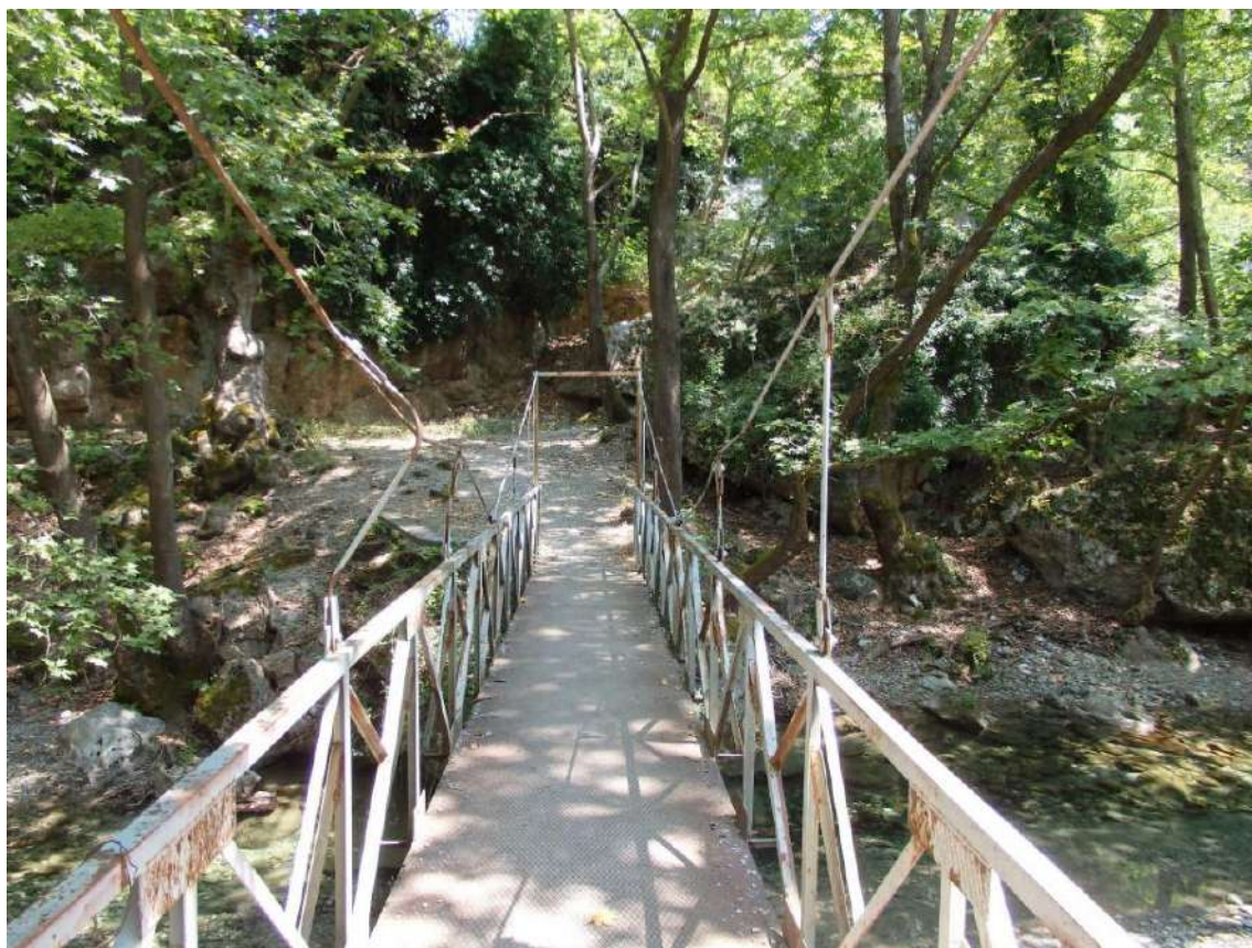
Φωτό 9: Στη φωτό διακρίνεται τμήμα της υπό συντήρηση μεταλλικής γέφυρας, με κατεύθυνση τη θέση «Μύλοι» Λιτοχώρου, ενώ κάτω από αυτή φαίνονται τα νερά του π. Ενιπέα.
