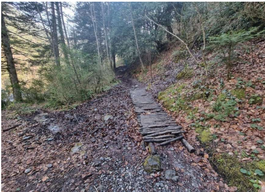
Φωτό 12: Το δεύτερο τμήμα της Ορειβατικής Διαδρομής 1 μήκους 28 m, θα γίνει επέμβαση βελτίωσης της βατότητάς του. Στη φωτο διακρίνεται και η υπό αποξήλωση πρόχειρη ξύλινη κατασκευή.
