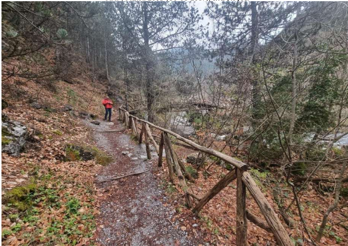
Φωτό 2: Υφιστάμενα ξύλινα προστατευτικά κιγκλιδώματα λίγα μέτρα πριν το τελευταίο γεφύρι (8 ο στη σειρά) του πρώτου τμήματος της Ορειβατικής Διαδρομής 1
